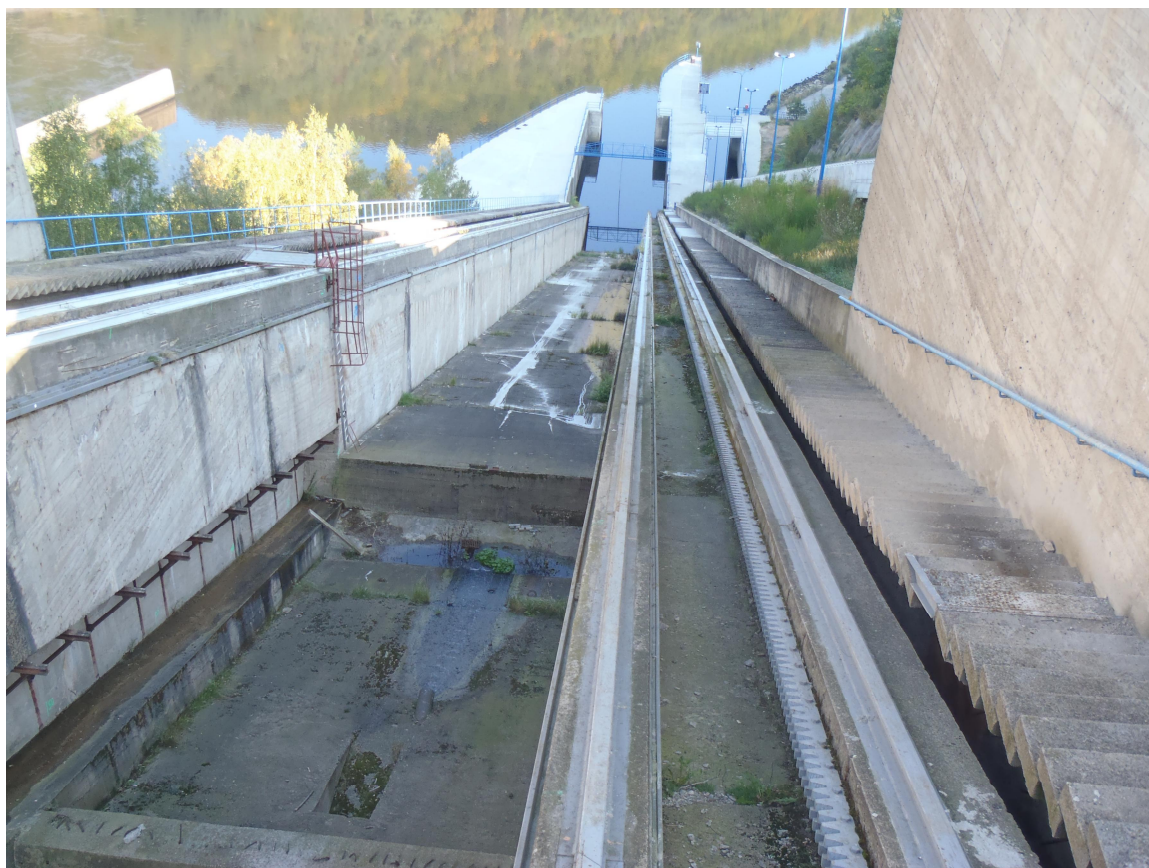
Pohled na stávající stav žlabu lodního zdvihadla na vodním díle Orlík
